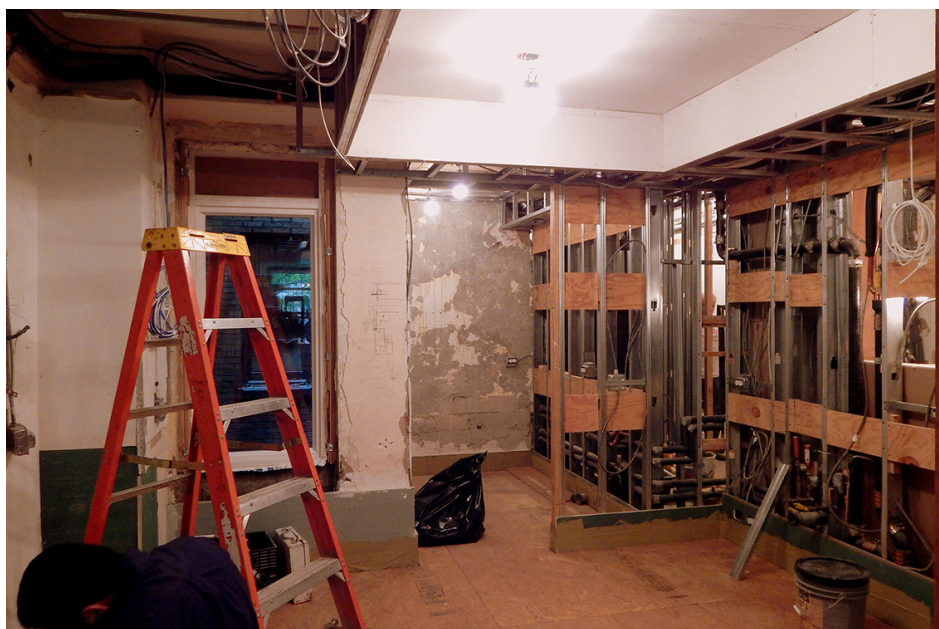
Montagem do steel frame na cozinha.
